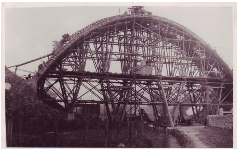
Épül a viadukt nagy íve
