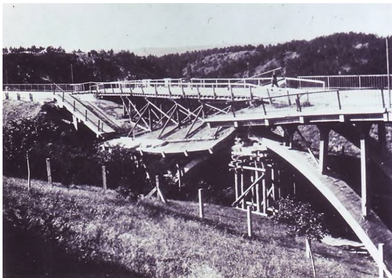
A felrobbantott veszprémi Viadukt kisíve
